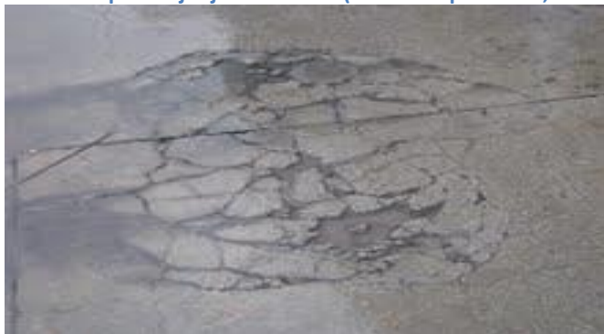
Slika 92: Vpliv soljenja na vozišče (vir: lastni posnetek, 2010)
